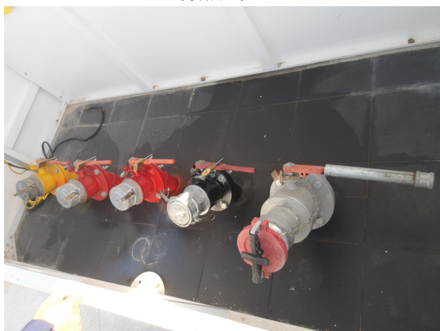
油气回收装置
