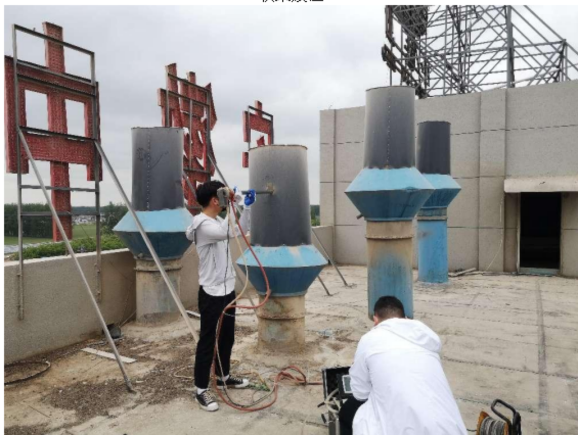
1#二清风网排气筒检测采样
