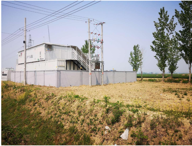
开关站回填及绿化情况
