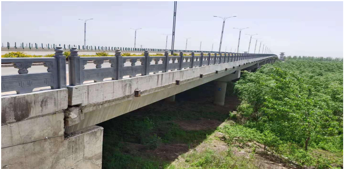
图9-10 新汴河河大桥桥体雨水排放口
