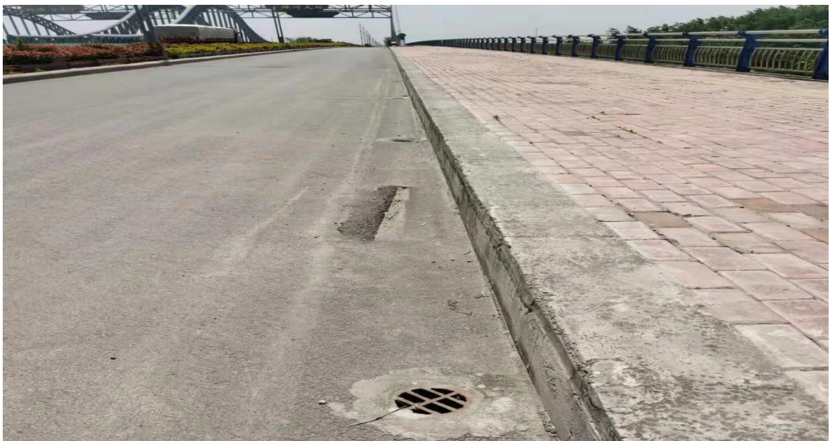
图9-7 新濰河大桥桥面雨水收集口
