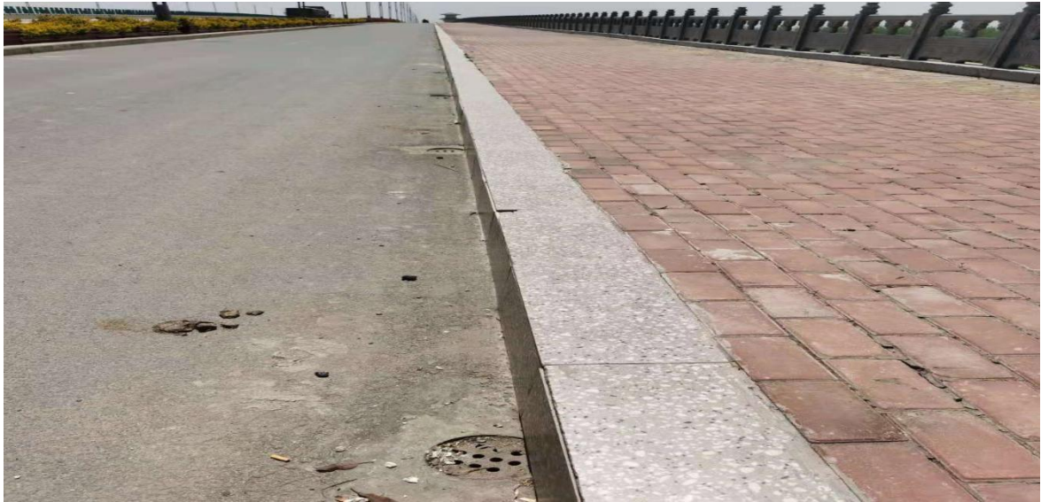
图9-9 新汴河河大桥桥面雨水收集口
