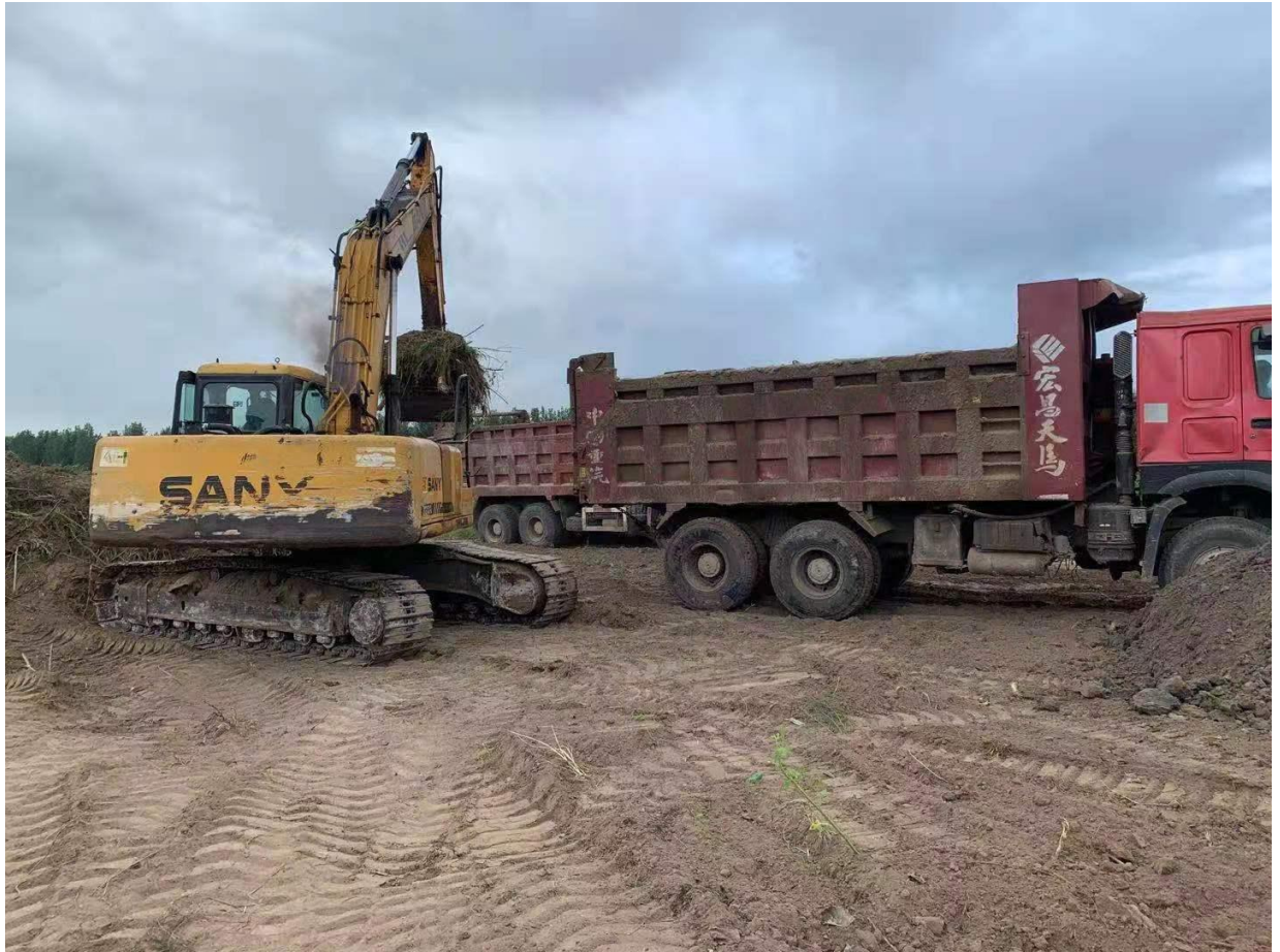
图9-1 施工期道路表层玻璃土取土
