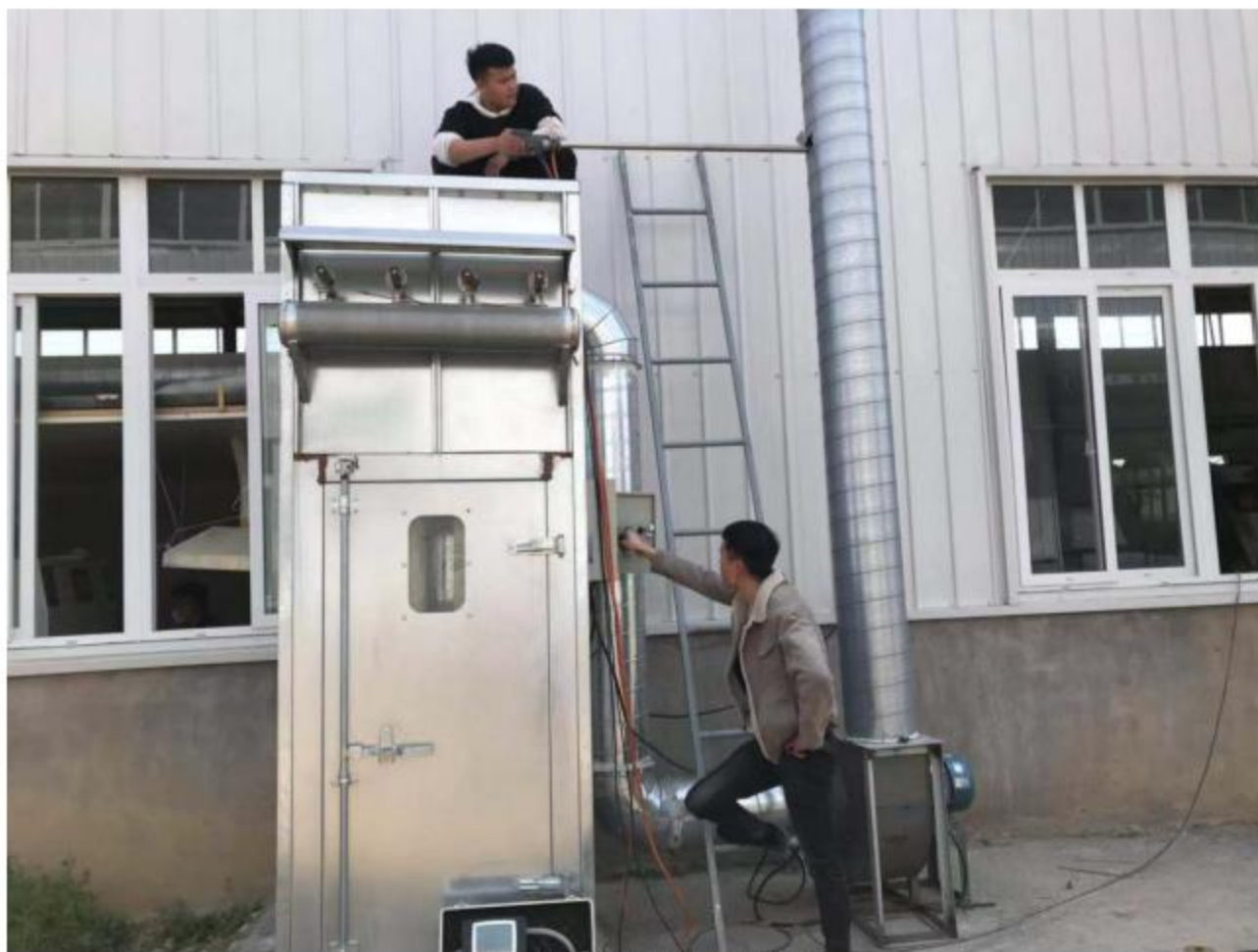
粉尘废气排气筒检测采样
